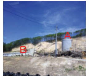
浄水場。タンク(A)の横に建っていた建物(B)が土砂で流された。
